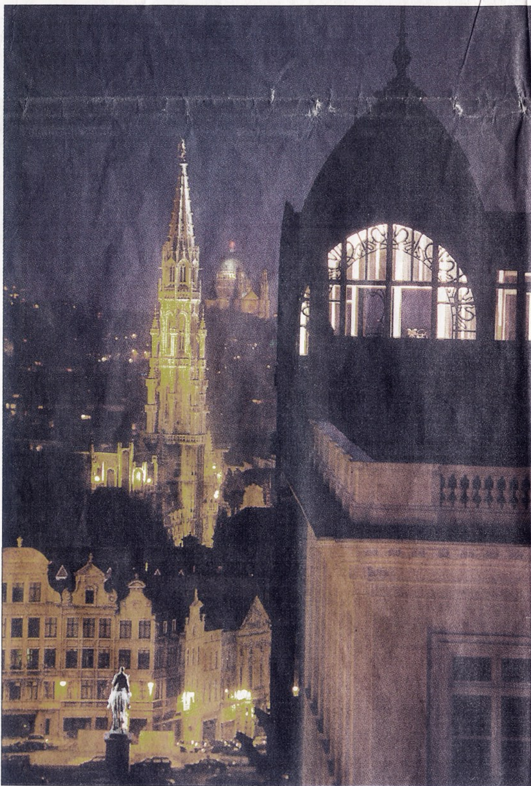
Avec les nouvelles combinaisons de luminaires, Bruxelles ne sera que plus belle la nuit. Photo Johan Jacobs.
